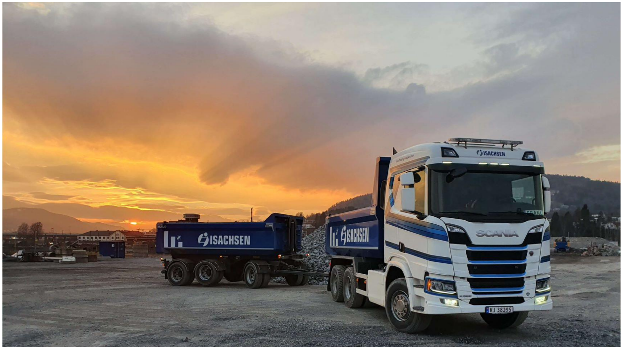
Pågående rivingsarbeider i forbindelse med bygging av nye Drammen Sykehus, Brakerøya.
